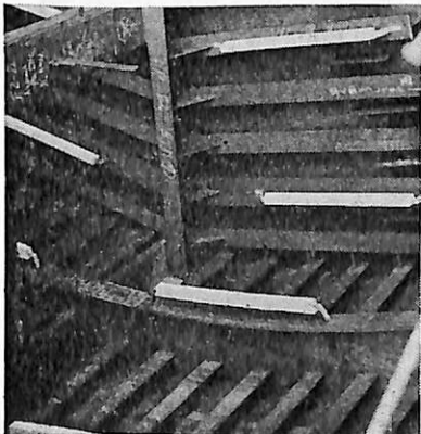
アルミ陽極取付 バラストタンク
