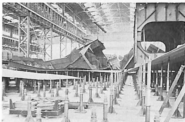
写真 16 非平行部ブロック組立工場
