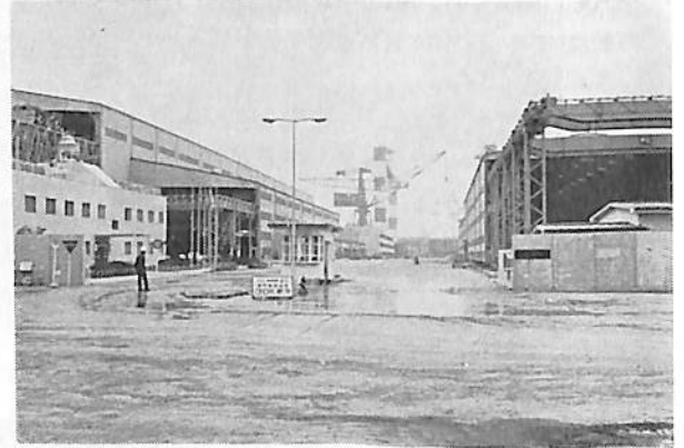
<正面より中央通り>
