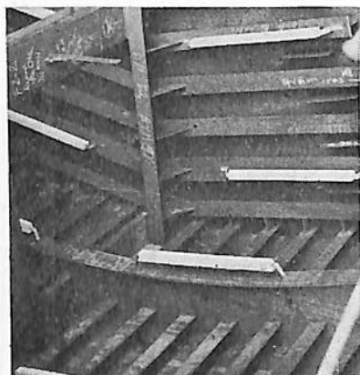
アルミ陽極取付 バラストタンク
