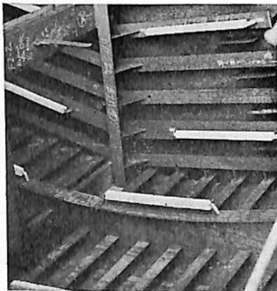
アルミ陽極取付 バラストタンク
