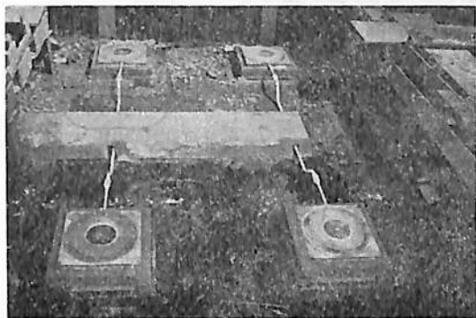
図6 エア・キャスタ設置状況
