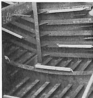
アルミ陽極取付 バラストタンク
