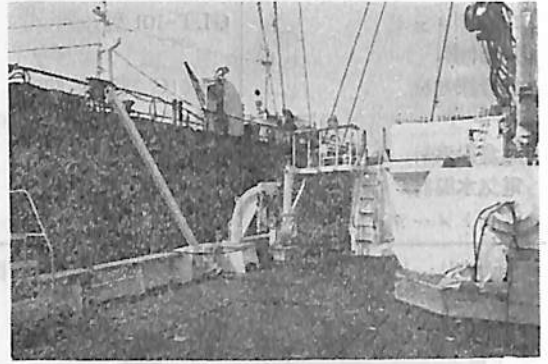
わかば丸 上甲板 (中央右玄) パースダビット, リングストリッパー
