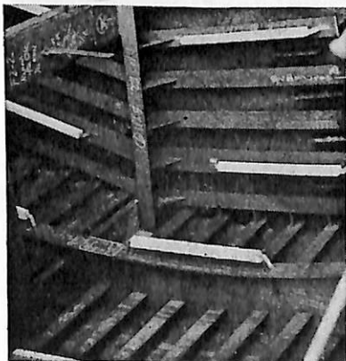
アルミ陽極取付 バラストタンク
