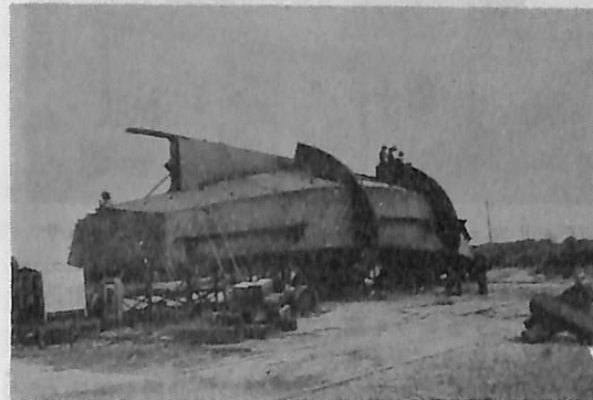
外板取付けを終ると，船側に転倒用の円盤を取付け，クレーンで転倒する。
