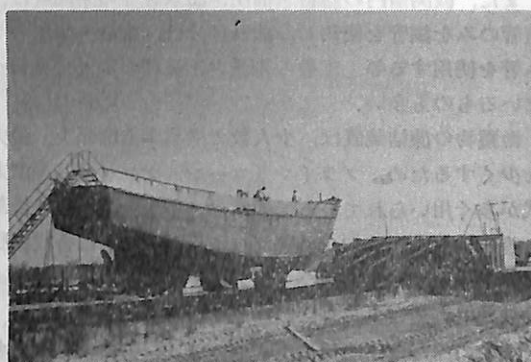
正常位置にセットし，甲板室等の搭載にかかる。
