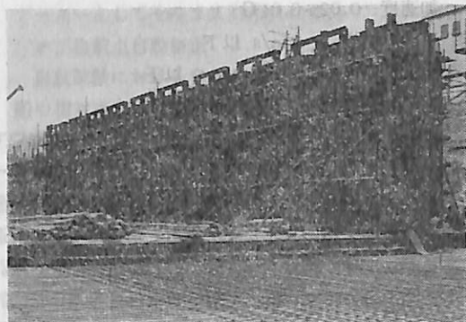
第7図 水槽建設工事(4)
