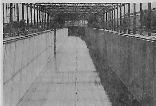
第9図 水槽建設工事(6)
