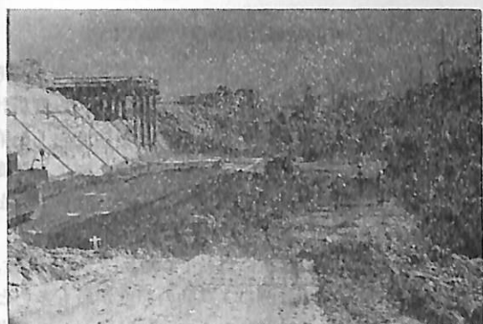
第5図 水槽建設工事(2)
