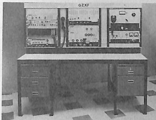
キャビネット型のレディフォン社の船舶用無線設備。
