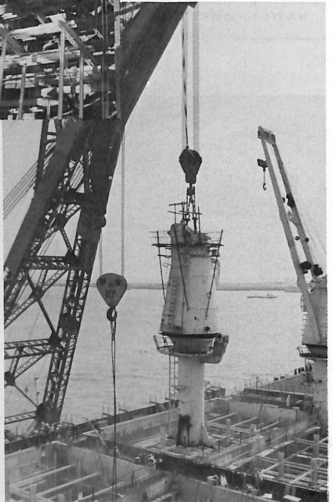
⑤中央デッキクレーンの移動作業中。
