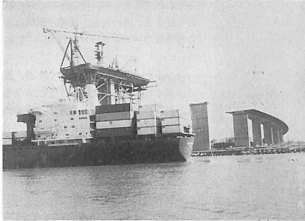
写真2 ウェストゲート橋
