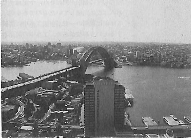
写真1 シドニーハーバー橋
