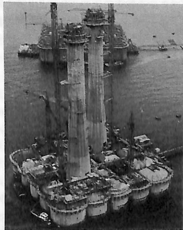
完成間近の北海用コンクリート・リグ
