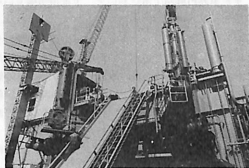
写真3 サブストラクチャー周辺を艦装中の「ペトロブラスII」
