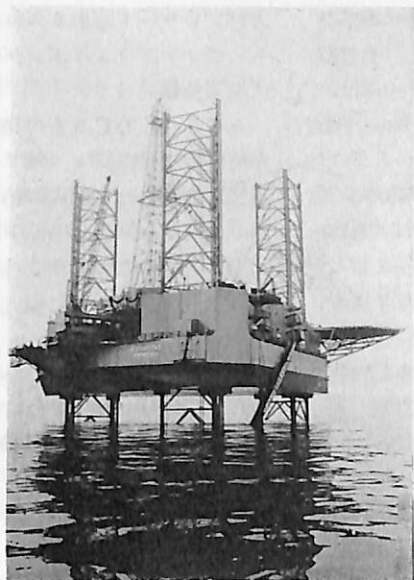
小豆島沖でテスト中の ジャッキアップ
