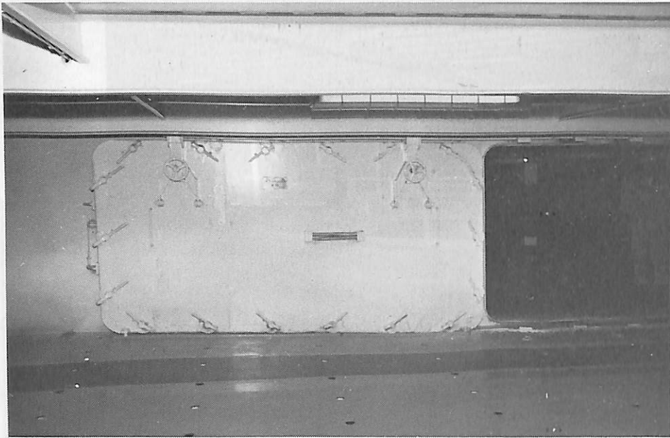
艙内の水密隔壁戸を開いたところ
