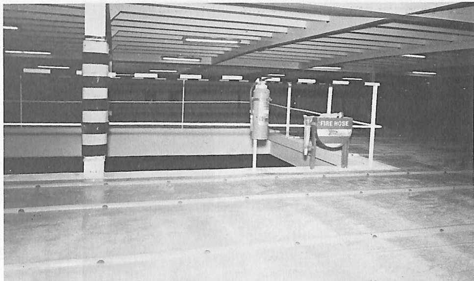
艙内ランプウエーの開口部
