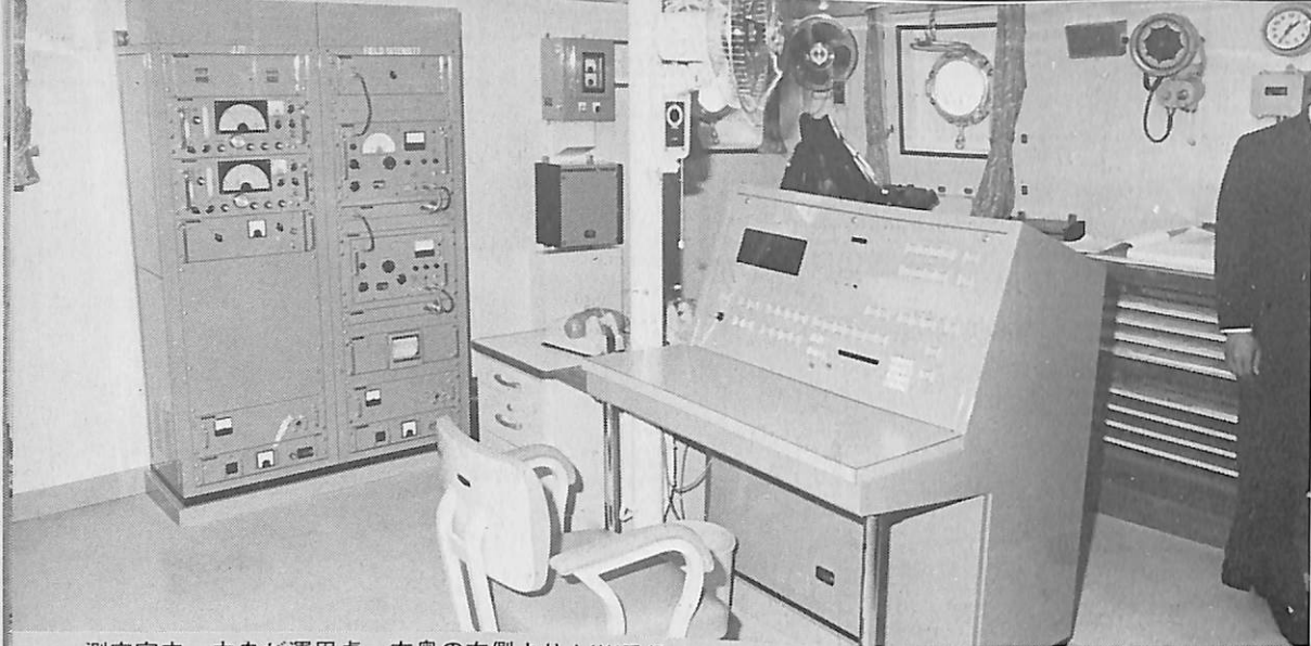
測定室内。中央が運用卓、左奥の左側よりJJW受信装置、電界強度測定装置がある。
