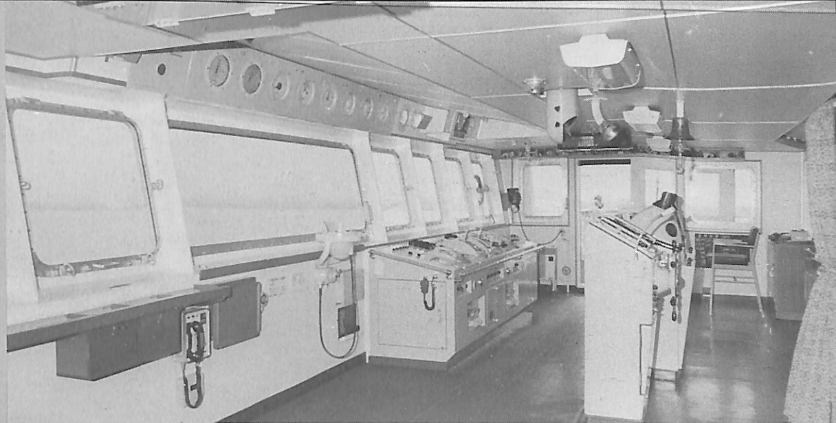
操舵室の内部。コンソール・ボックスと2台のレー ダを操舵スタンドの右舷側に配置し、コンソール天
