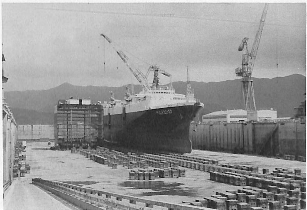
写真5 本船および中央延長船体をKRDに入 渠し据付する。8月23日完了。
