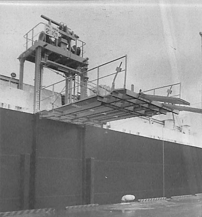
左舷中央部に取付けられた上甲板に至る小型 車輛用のカーリフター
