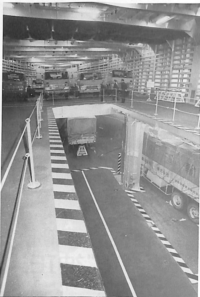
カーゴリフターの主甲板開口部 (Lower Positionのリフトを主甲板より望む)
