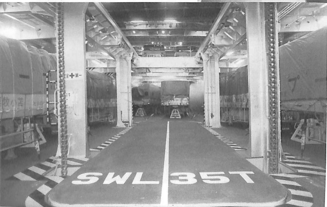
船尾方向より見た Lower Position。主甲板 と二重底頂部間に設置された SWL35T のカー ゴリフター
