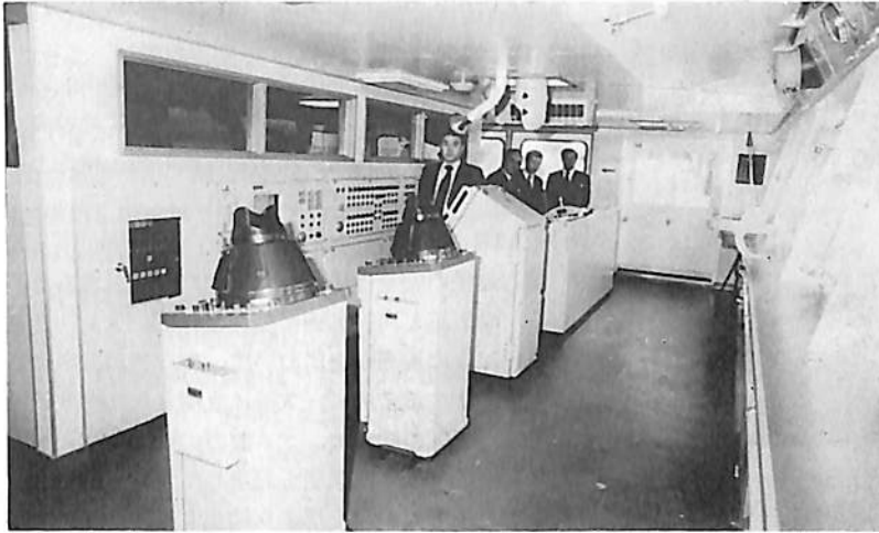
主機リモコン、スラスター制御盤を含む航海コンソール、オートパイロット、レーダー等を備えた船橋内部
