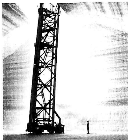
図 2-23 内部防熱タンク内部
