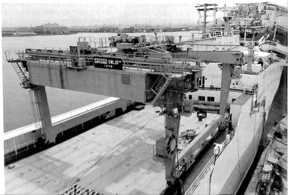
●10Tガントリークレーン
