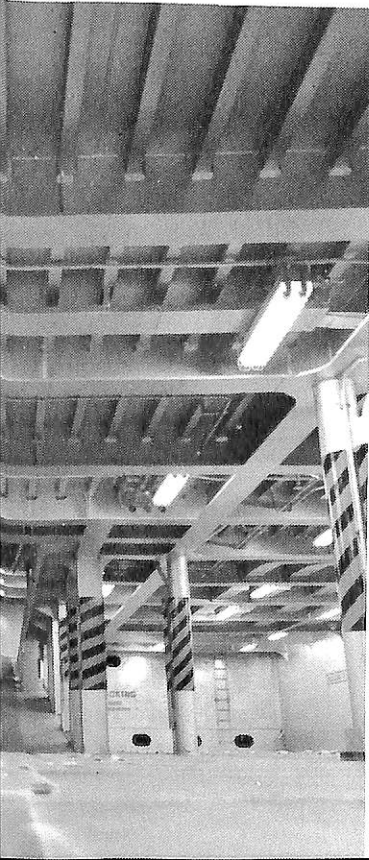
船首から船尾を見る
