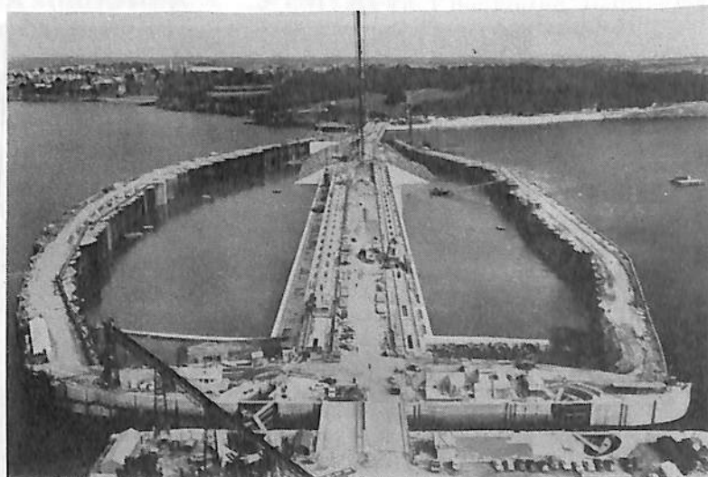
第10図 建設途上のランス発電所
