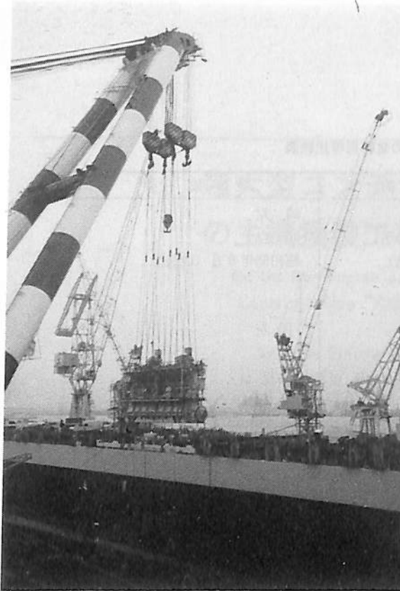
3,000 T海上クレーンにより主機関を搭載中
