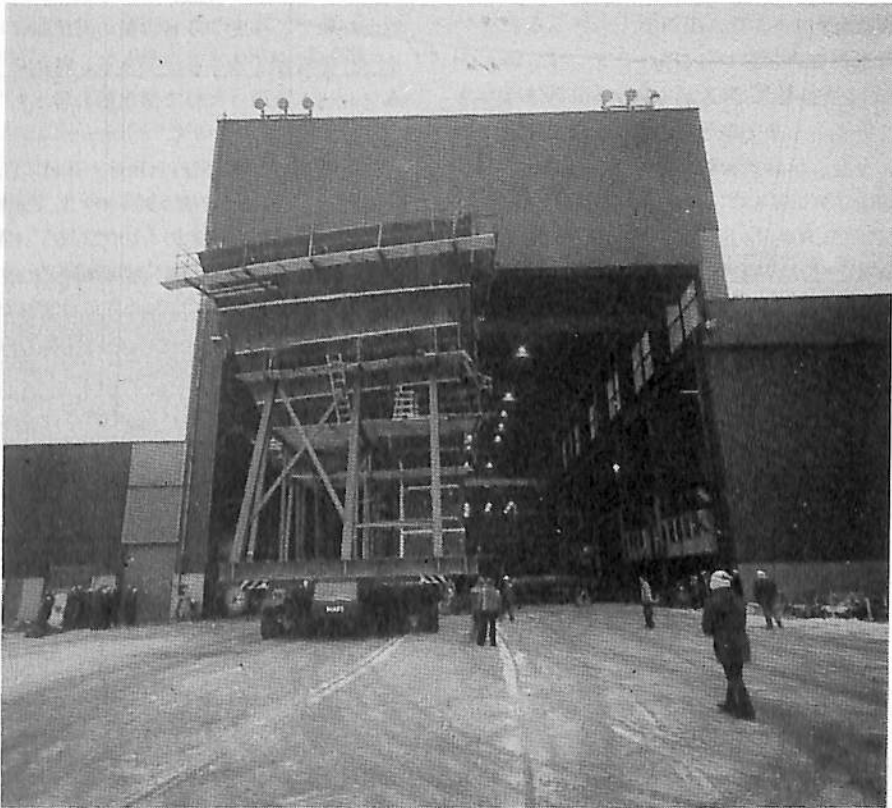
第6図 水海石油掘削船の船尾部
