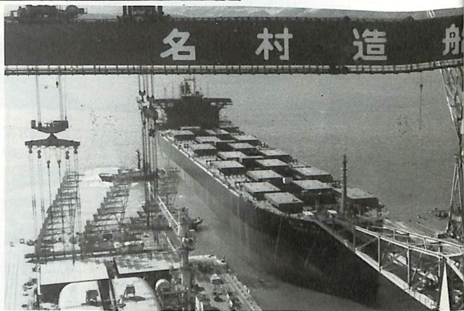
進水時、ハッチカバーと居住区まで搭載完了。
