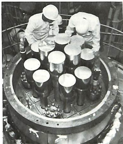
原子炉容器蓋部の遮蔽体取付け作業
