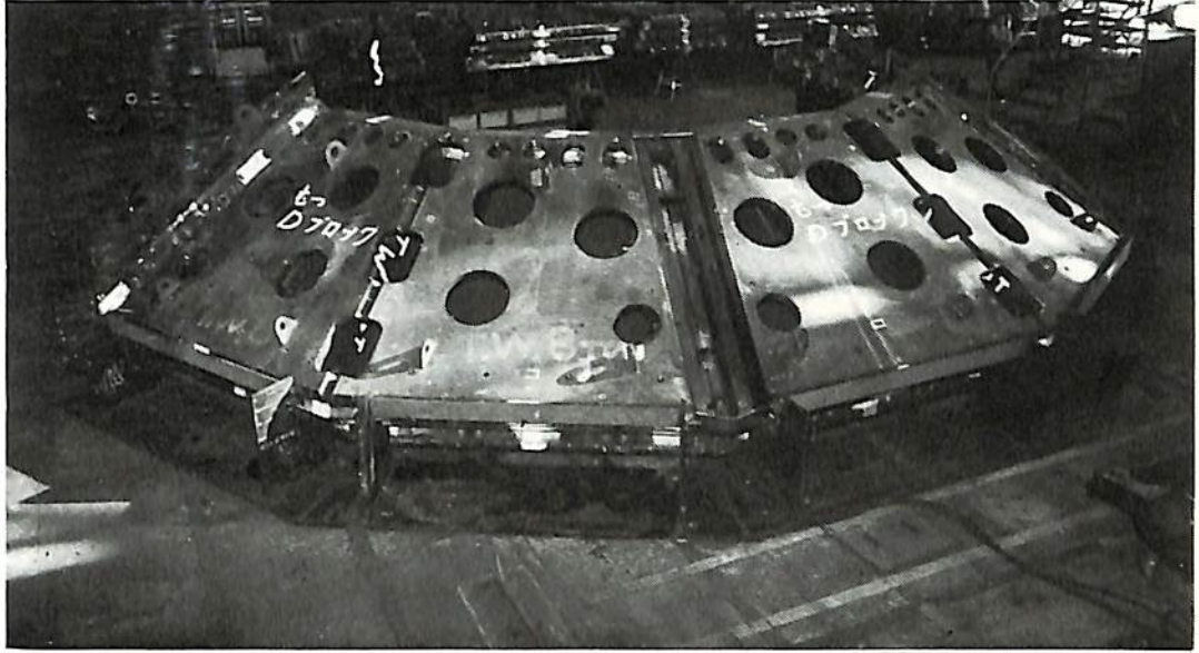
新しく取り付けられる格納容器上部の二次遮蔽体
