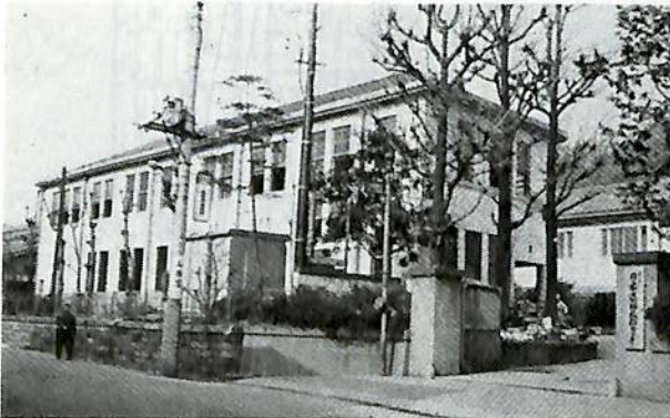
改築前の造船技術センター
