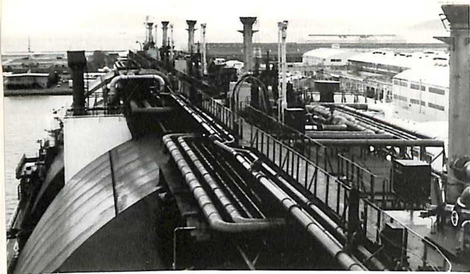
上甲板タンク カバー上配管 を見る。
