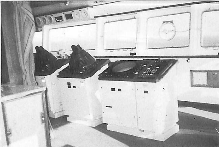
操舵室。レーダーと並んで衝突予防装置がある。
