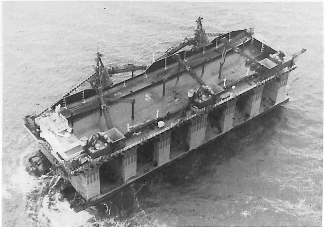
鉱石積み換へプラットフォーム
