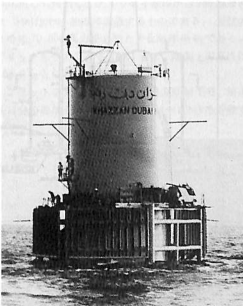
着底したタンク上部構造
