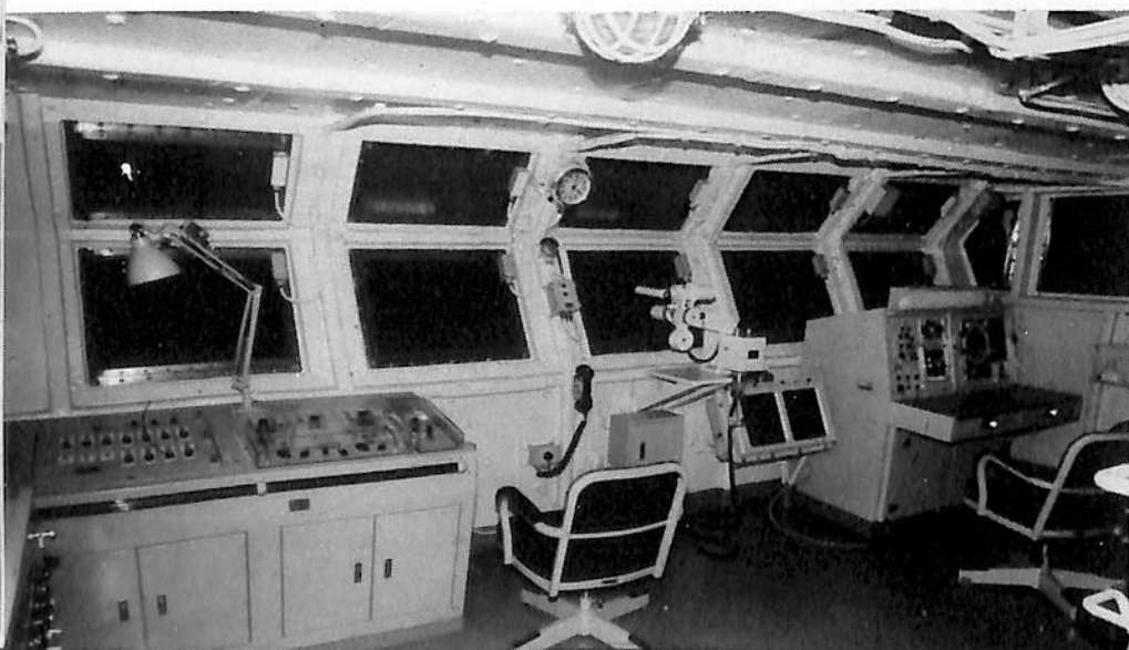
③ 発着管制室内。監視窓は飛行甲板および上方の視界を良くするため“く”の字に前方に曲っている。
