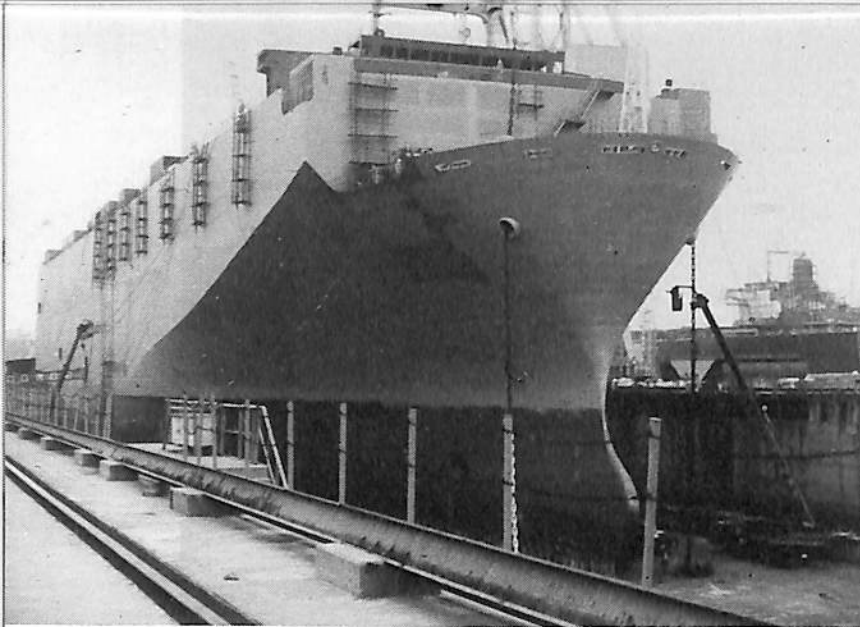
工事中の“ぐるーばるはいうえい”
