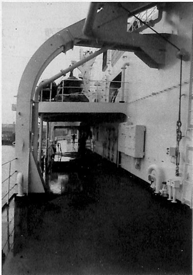
⑤ 01甲板の両舷通路(写真は右舷側)は巾が広く、物資移送用のフォークリフトやパレットトラックの走行が非常にスムーズ。
