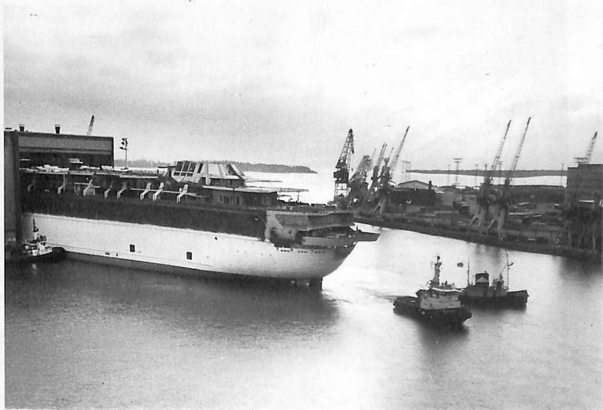
進水後、2隻のタグボートにより、ヴァルチラ社ヘルシンキ造船所自慢の全天候型ドライドックから引出される所。バイキング・クラウン・ラウンジが、ドック棟の高さの関係から未完成であることに注目を。
