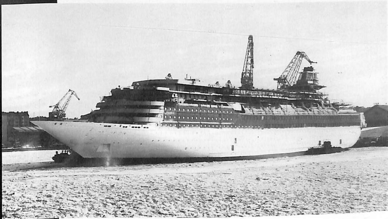
進水後、ヴァルチラ社ヘルシンキ造船所の結氷水面に引き出され、艤装中の様子。この段階で、バイキング・クラウン・ラウンジが取はけられた。
