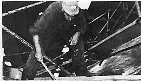
船殻のFRP積層成形(ハンドレイアップ成形法)
