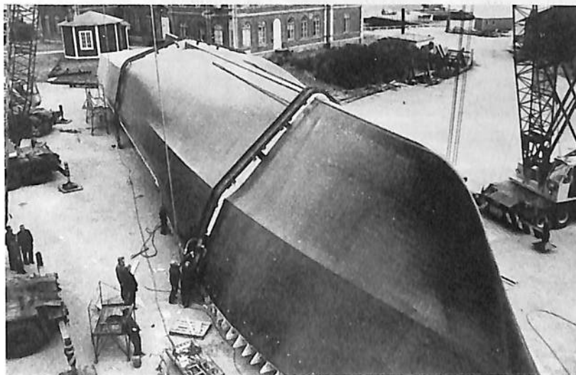
FRP外表面の積層成形完了
