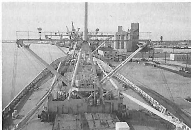
船首部の荷役装置
