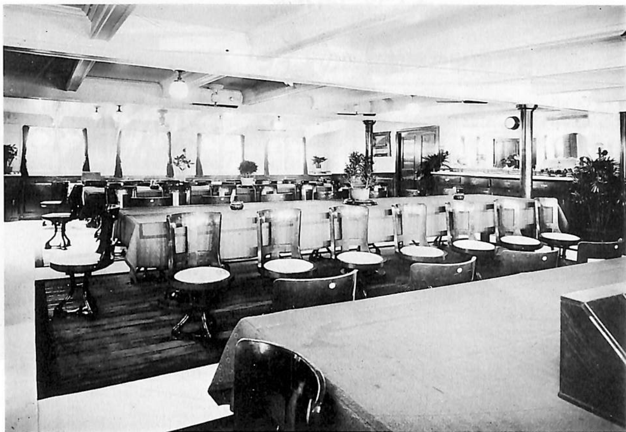
【二等食堂】シェルター・デッキ最前部に設けられ、両舷いっぱい に造られていた。天井には扇風機が取り付けられ、床の一部には板 張りが露出している。
