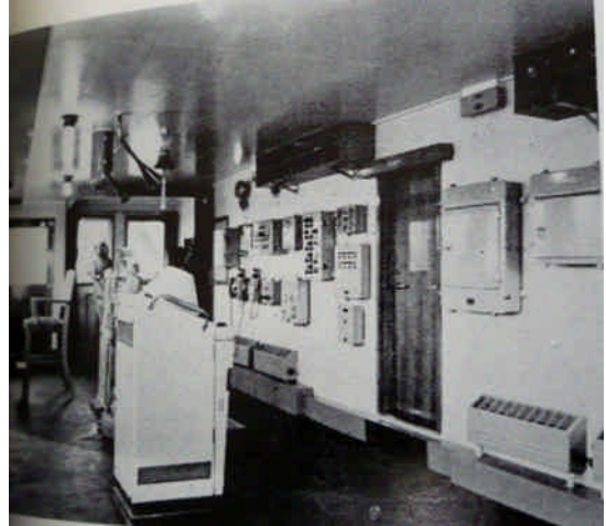
3) W37-03 「利洋丸」 機関室 配電盤
